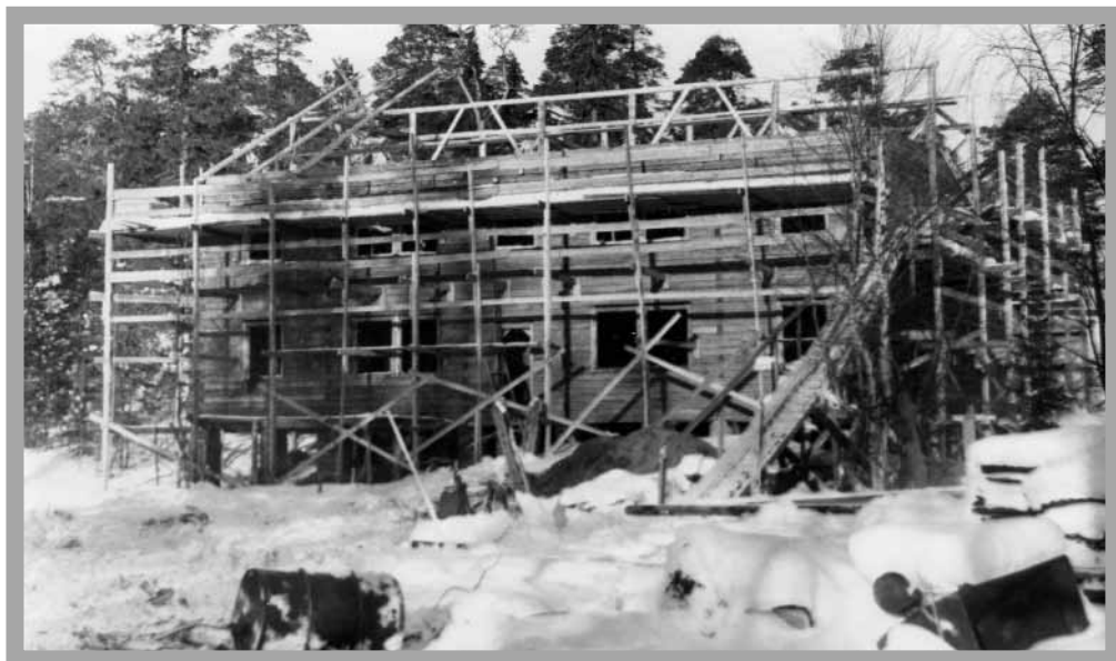
Строительство "Бастилии". Фото из архива Л. П. Флячинской
